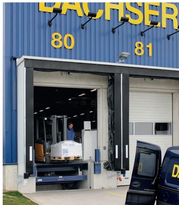
升降式装卸平台将伸缩式平台与剪式升降台有机结合在一起
